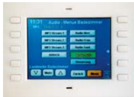
Musik lässt sich via Bedientableaus von der sich im Technikraum des Kellers befindlichen Festplatte abrufen.
